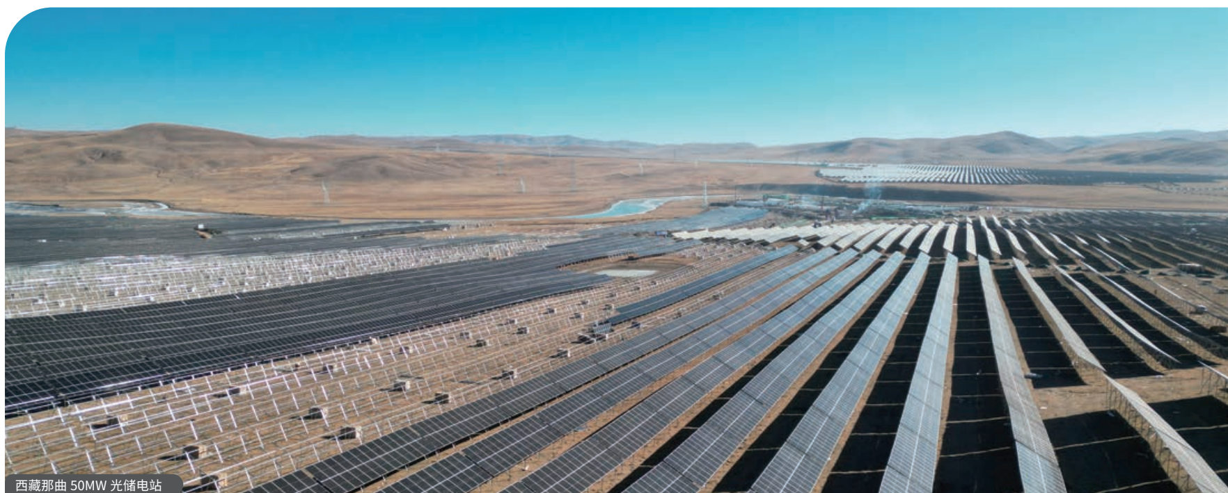
西藏那曲 50MW 光储电站
